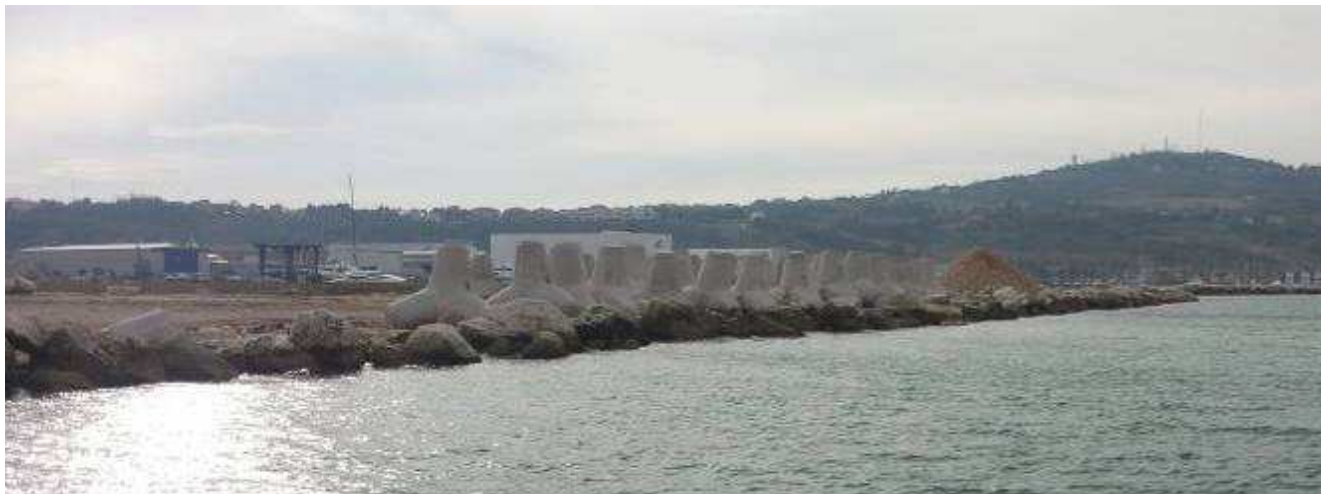
Figura 3: Zona di mare antistante la scogliera dove infiggere il palancoolato e realizzare la banchina n.27
